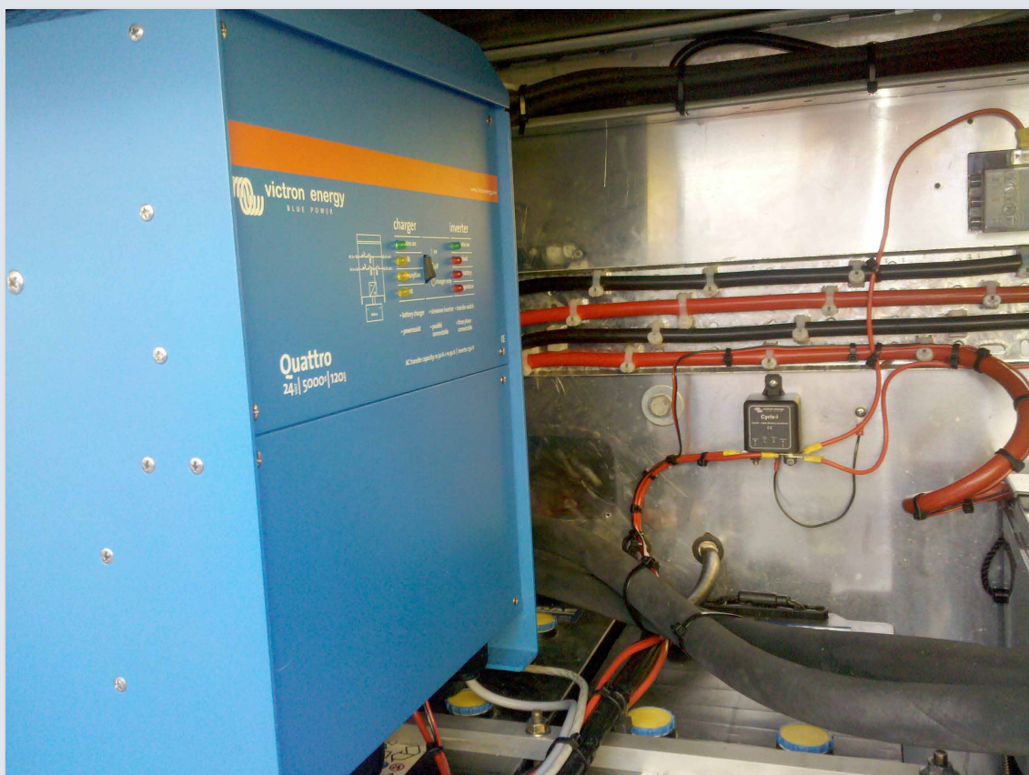
Foto 3: De Victron Quattro 5kVA levert altijd 230V spanning.
