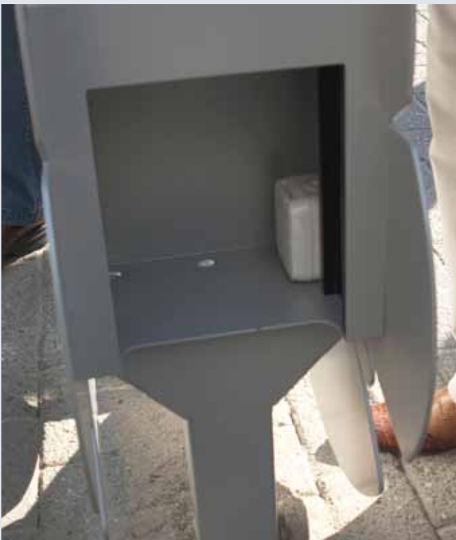
Foto 8 & 9: Het oplaadpunt bevindt zich in een waterdichte behuizing, welke omhoog geschoven kan worden.
