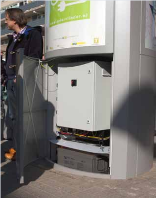
Foto 6 & 7: De Victron accu's en de MultiPlus zijn ingebouwd in de pilaar.
