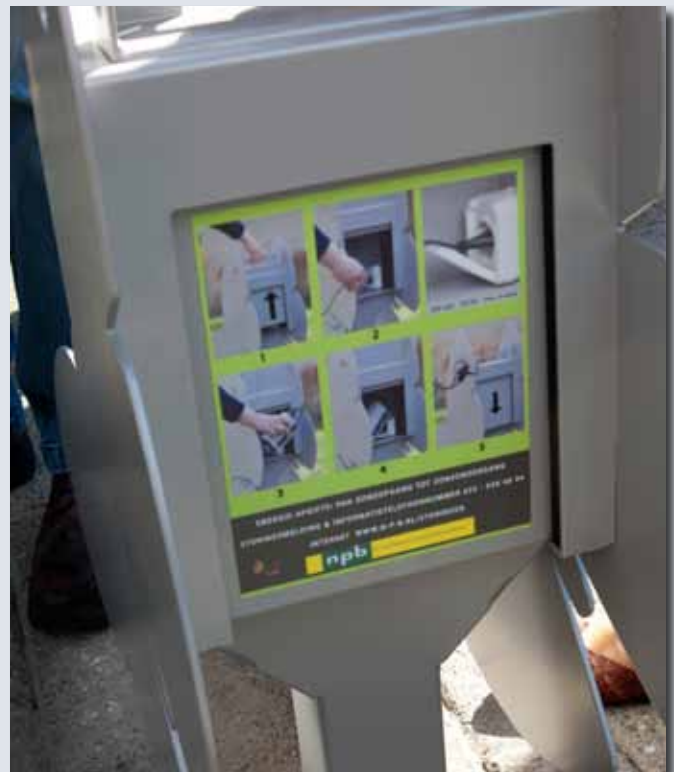
Foto 8 & 9: Het oplaadpunt bevindt zich in een waterdichte behuizing, welke omhoog geschoven kan worden.
